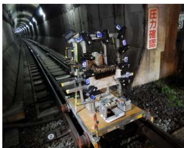
鉄道トンネル
